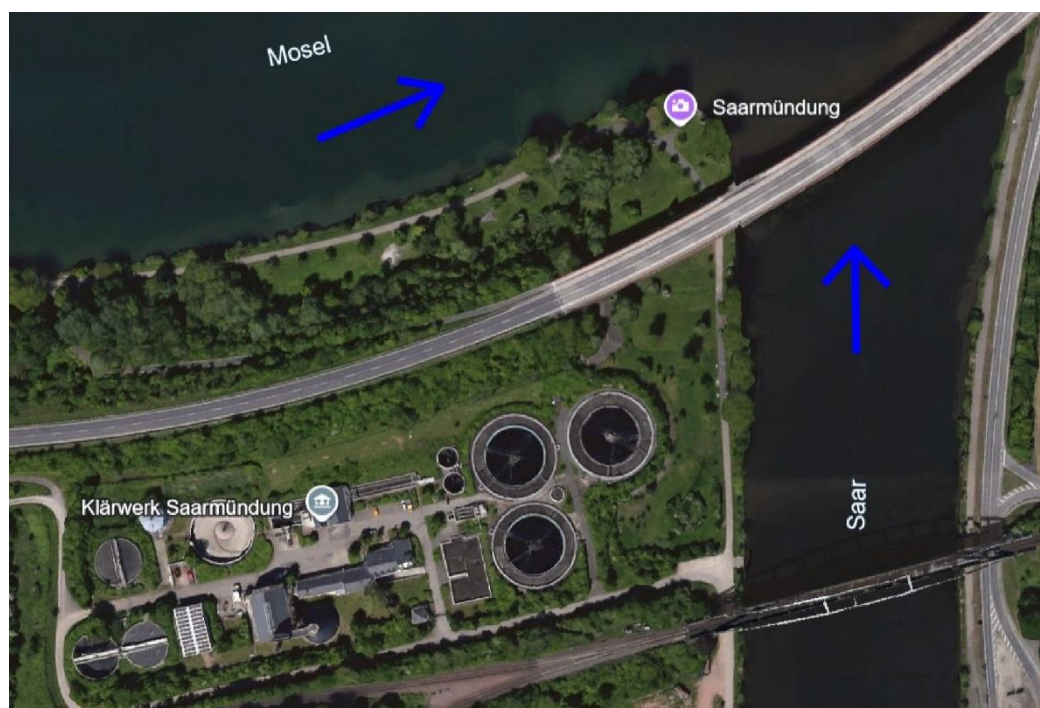
Abbildung 24: Luftbild des Klärwerks mit Kennzeichnung der Fließrichtung der Saar und Mosel
