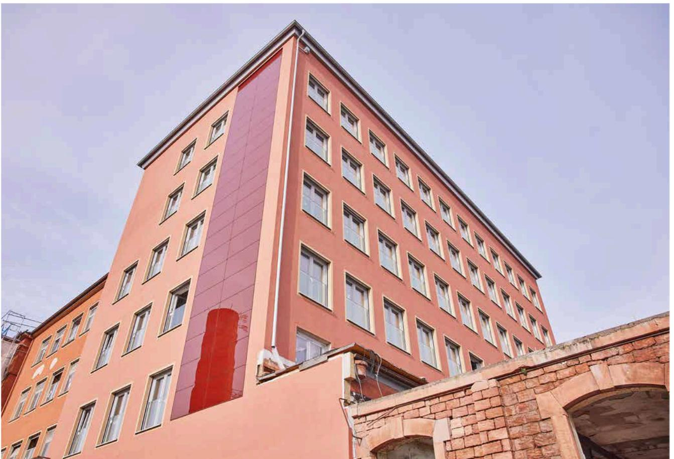
Auch bei baukulturell wertvollen Gebäuden lassen sich Dach- und Fassaden-PV mittlerweile denkmalgerecht integrieren, beispielsweise mit Solarmodulen in entsprechender Farbgebung.
