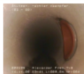
Sanierter Hausanschluss
