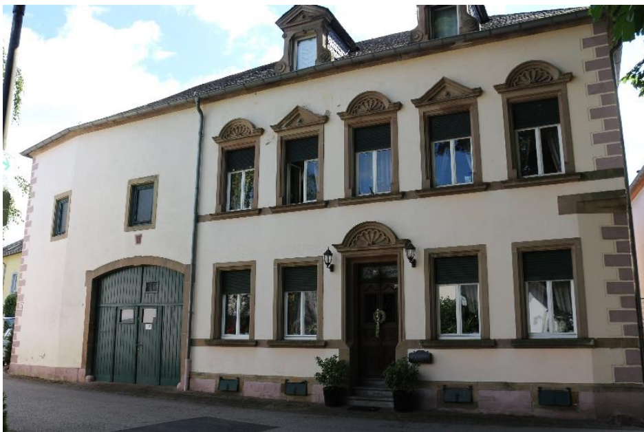
Foto: Denkmal in der Kirchstraße mit Sockel und hohem Drempele
