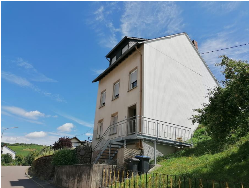
Foto: Haus am Hang mit hohem Sockel und hohem Drempel am Hang
