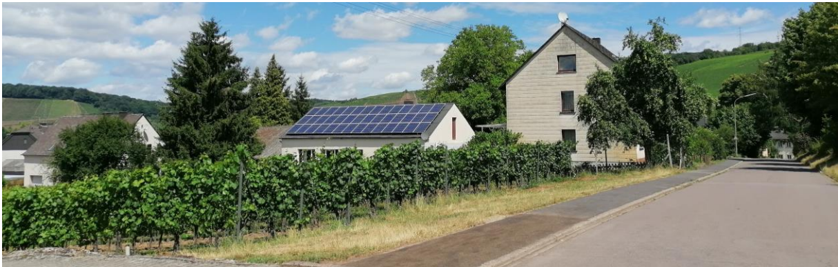
Abb. Auch auf hinteren Bauten im Garten stören sie die Dachlandschaft weniger, bei dunklen Randprofilen gar nicht.
