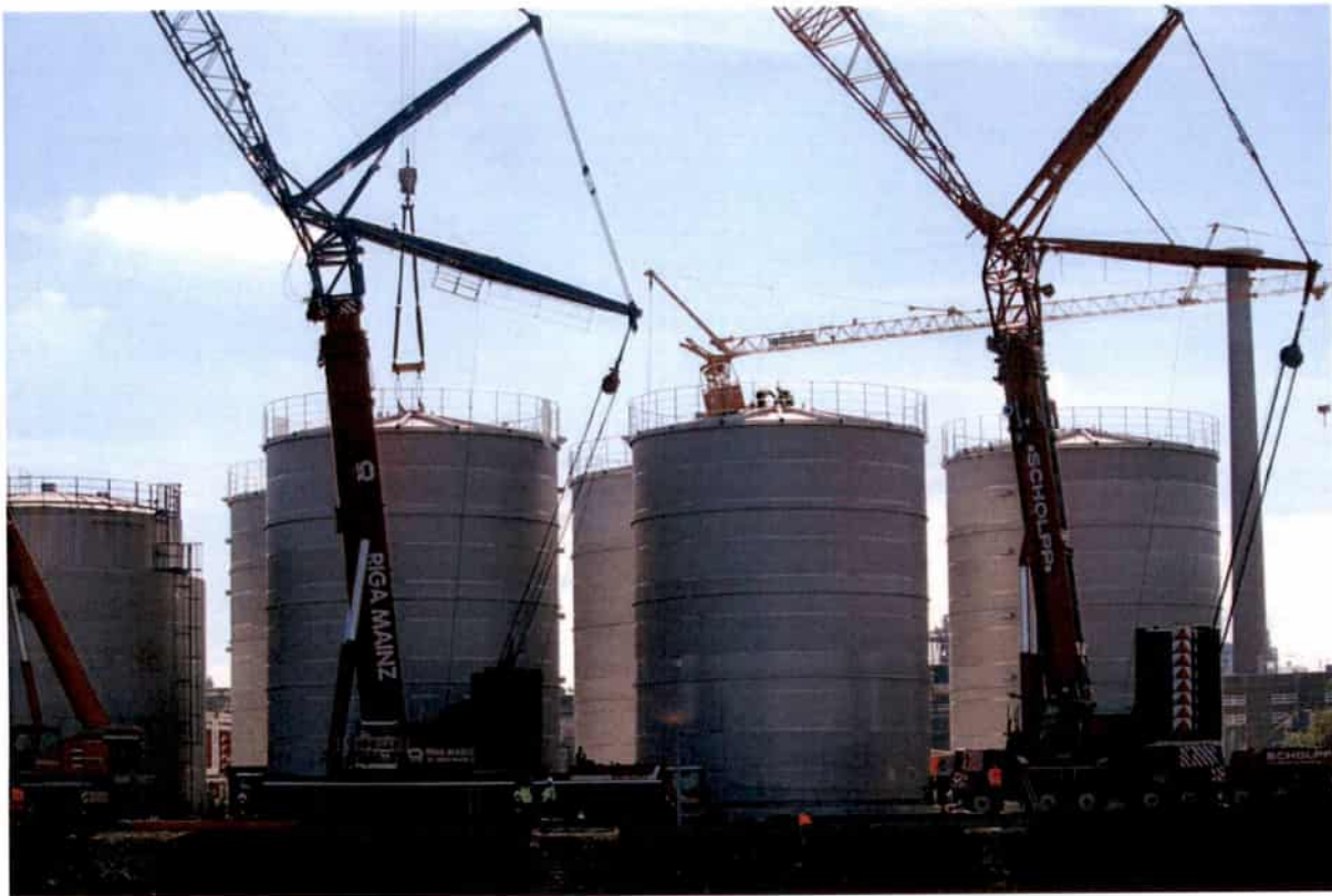
Abbildung 40: Tankinstallation mittels Standardbauteilen und mit Hilfe von Mobilkränen (Beispiel)
