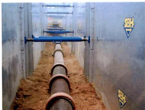
Abbildung 37: Maßnahmen der Baugrubensicherung, hier: Boxenverbau
