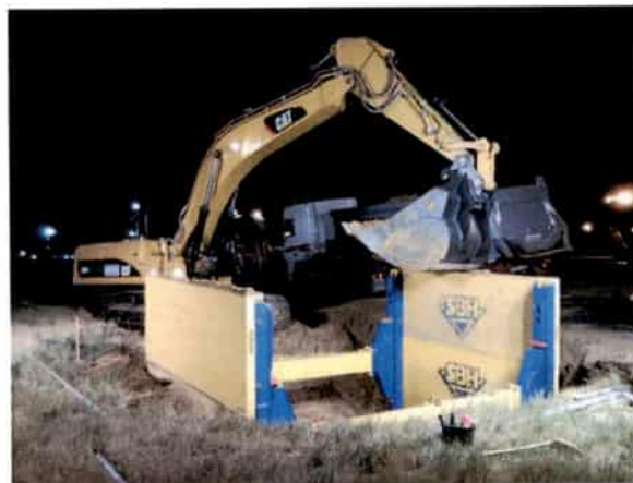
Abbildung 37: Maßnahmen der Baugrubensicherung, hier: Boxenverbau
