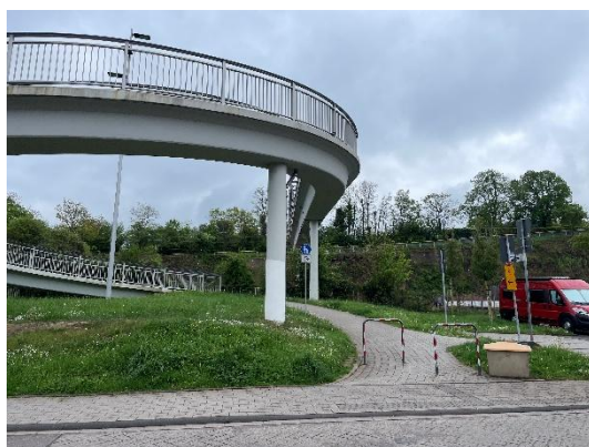
Abbildung 59: Brienon-Brücke (links und rechts)
