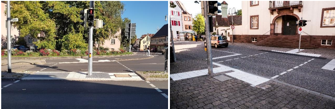
Abbildung 16: Beispiele für barrierefrei ausgebaute Lichtsignalanlagen
