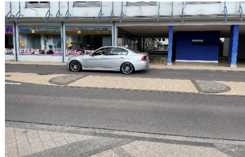
Abbildung 10: Mittelinsel ohne Bodenindikatoren an der Schillerstraße
