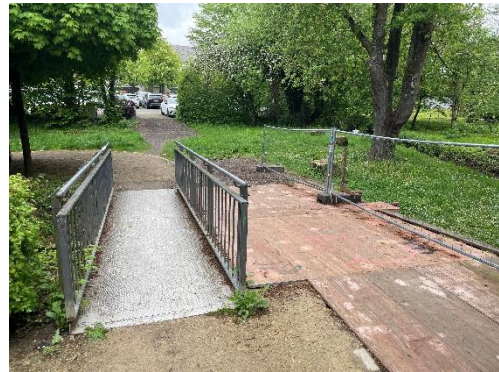
Abbildung 32: Bestehende Brückensituation am Fußweg Markt – Bahnhof
