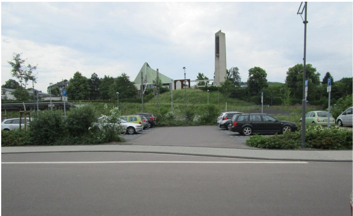
Ausbau der Bahnhofstraße: Bahnhofstraße 3. BA
